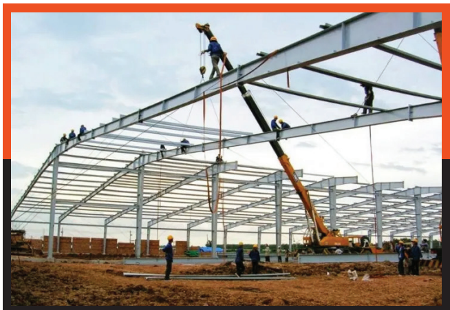
Lắp dựng nhà xưởng
